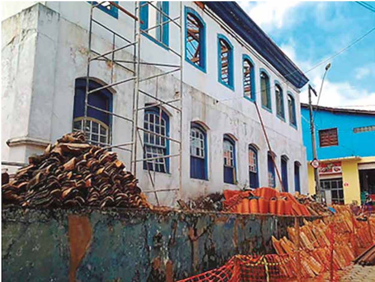
Prédio da Prefeitura é um dos mais importantes bens em restauração.
